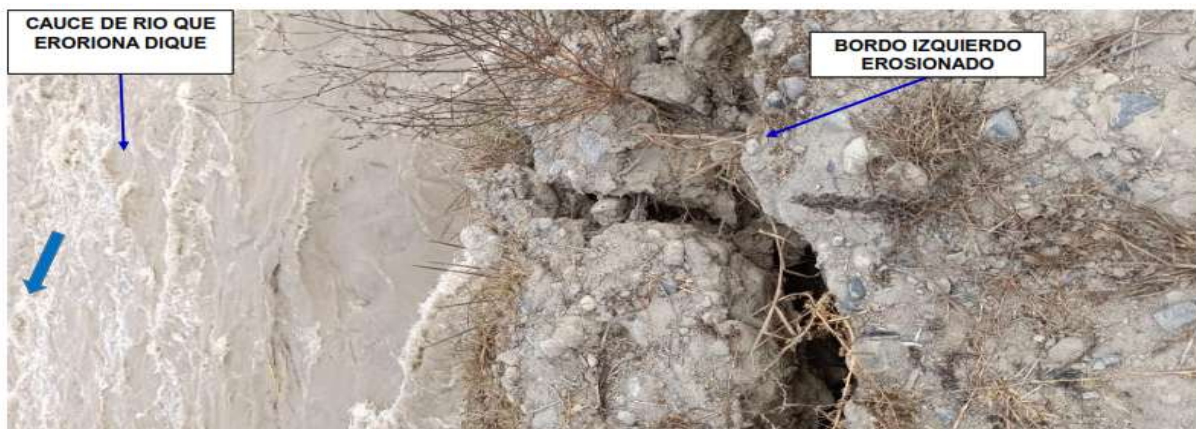
FIGURA N°02: RIO CHANCAY HUARAL, SECTOR MENTECHICO CON EL CAUCE COLMATADO E ISLAS DE FLUJO DE DETRITOS QUE DESVIA EL CAUDAL DEL RIO PRINCIPALMENTE HACIA LA MARGEN IZQUIERDA CON EROSION AVANZADA.
