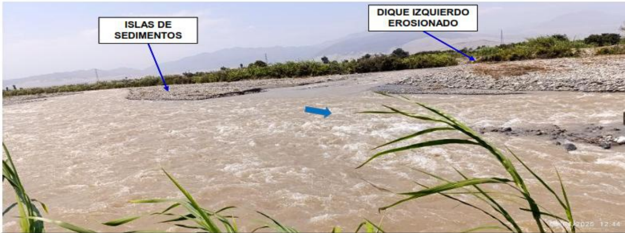
FIGURA N°02: RIO CHANCAY HUARAL, SECTOR MENTECHICO CON EL DIQUE EROSIONADO Y EL CAUCE CON PRESENCIA DE ISLAS MUY PRONUNCIADOS QUE DESVIA EL CAUDAL HACIA LAS MARGENES CAUSANDO EROSION A LOS DIQUES.
