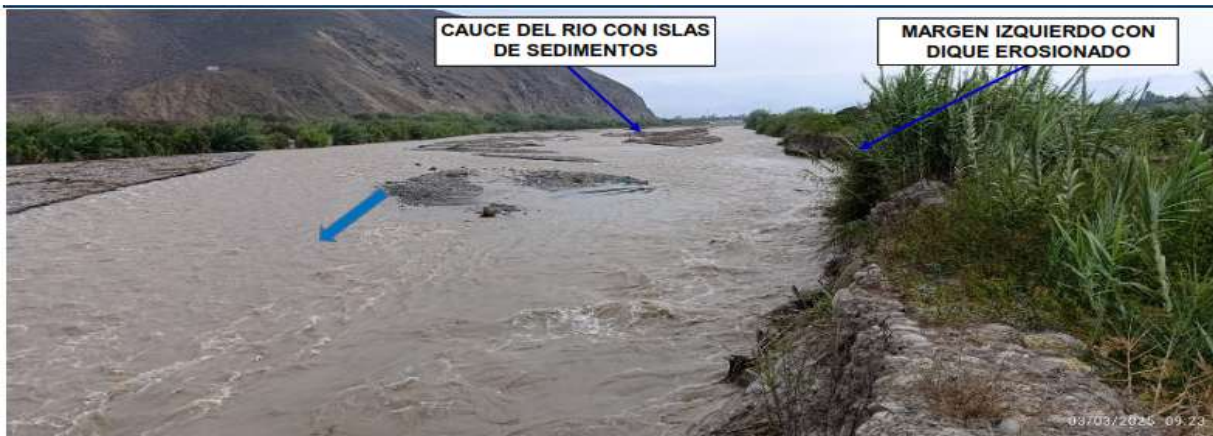
FIGURA N°01: TRAMO CRITICO EN EL RIO CHANCAY Y HUARAL CON EL CAUCE COLMATADO Y PRESENCIA DE ISLAS DE FLUJO DE DETRITOS, MARGEN IZQUIERDO ES EL SECTOR MANCHURIA CON EL DIQUE EROSIONADO Y EN TODA LA MARGEN DERECHA DE ESTE TRAMO SE ENCUENTRA EL CANAL CD SALINAS ALTO.
